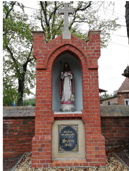
Kapliczka św. Idziego po remoncie
