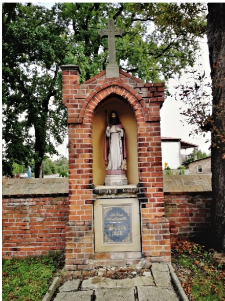
Kapliczka św. Idziego przed remontem
